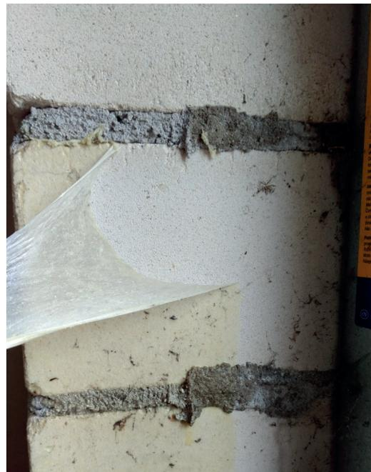
Tragen Sie ASG COVER mit dem Farbroller auf den mit Schimmelpilzen befallenen Bereich auf. Es entsteht ein milchig-weißer Belag, der sich aus der Zusammensetzung der Emulsion ergibt.
